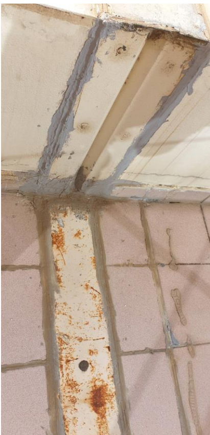
Αρμός διαστολής μπαλκόνι 3 ου ορόφου
