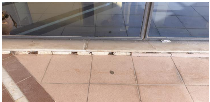
Μπαλκόνι 1 ου ορόφου
