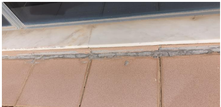
Μπαλκόνι 3 ου ορόφου
