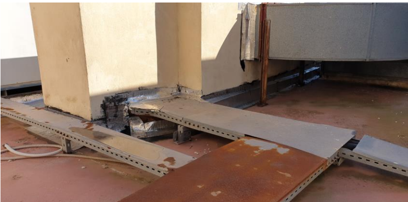
Σημεία επαφής μηχανημάτων και Shaft δώματος
