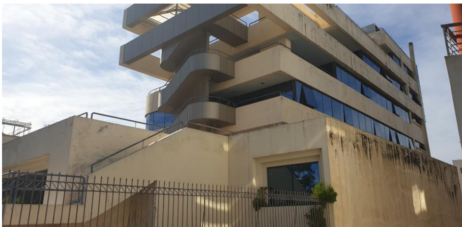
Βόρεια όψη κτιρίου
